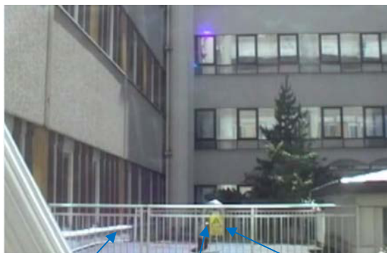
立入制限区域 (固定式フェンス) 排気口 注意喚起標識
