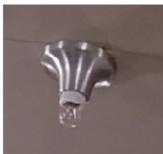
図 2 1) バッテリー別置型非常照明例 (露出型)
