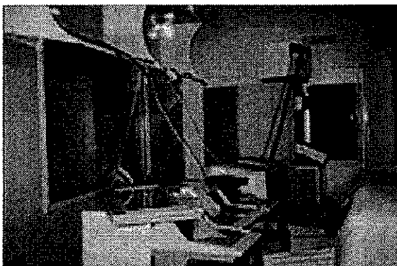
⑧ 壁付モニターの落下 モニターと架台が固定されていなかった。
